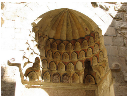
Schmuckelement über einem Durchgang
