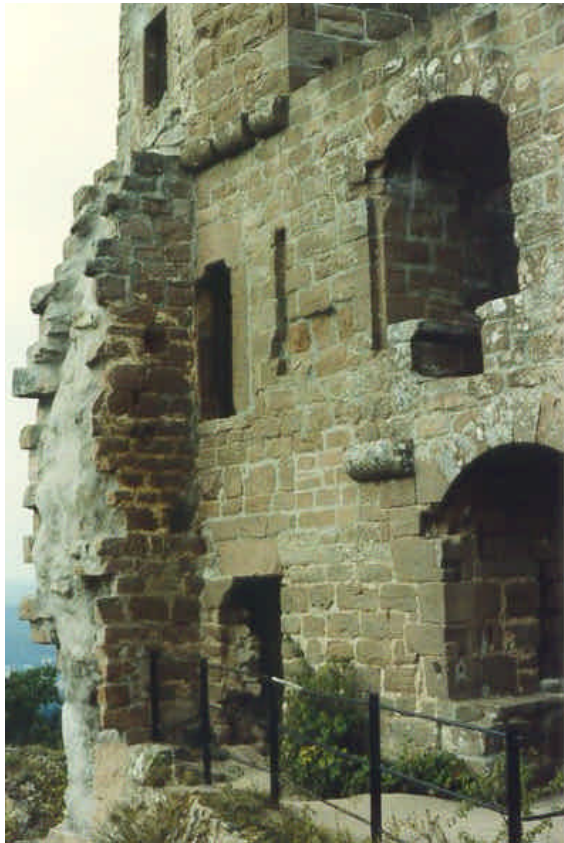
Abbildung 15. Altdahn: Palasinnenwand und Bergfried, 1991. Aufnahme des Verfassers.
