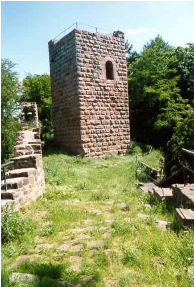
Abb.: 8 Ansicht des Bergfrieds von Südwesten, 1991. Foto des Verfassers.
