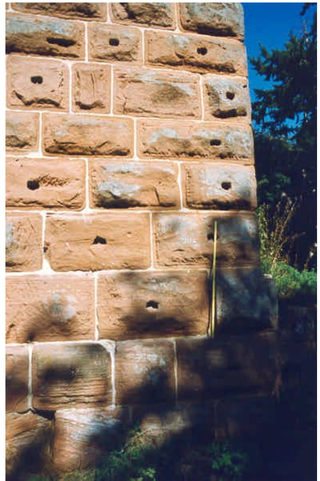
Abb.: 7 Buckelquadermauerwerk des Bergfrieds an seiner Südseite, 1991. Der Maßstab im Bild ist 1m lang
