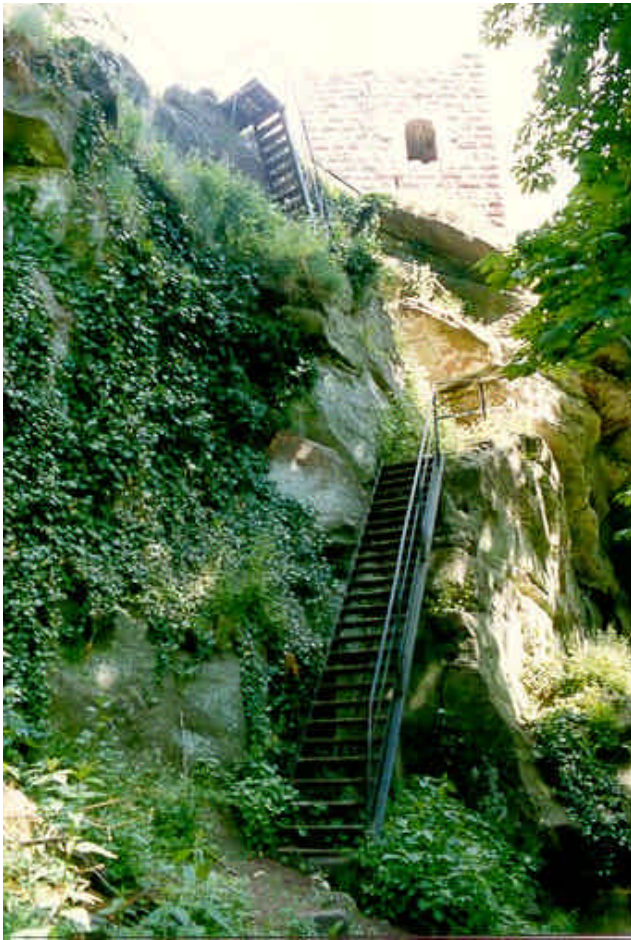
Abb. 4. Zugang zur Oberburg der Ostanlage, 1990, Foto des Verfassers.
