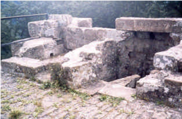
Abbildung 10. Blick auf den nördlichen Teil des heute offen liegenden Obergeschosses der Bergfrieds Groß-Amsberg, 1992. Links der "Sanitärraum", rechts die Wendeltreppe. Foto des Verfassers
