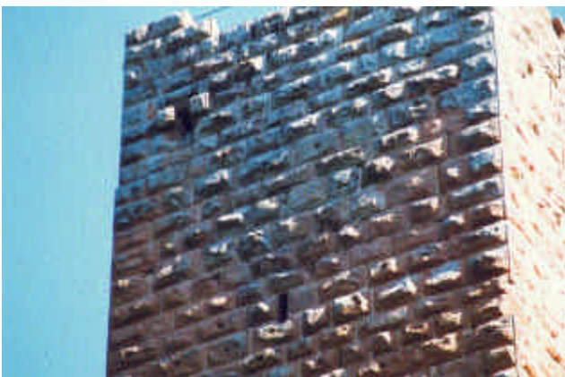
Abbildung 11. Ansicht der nordwestlichen Außenwand des Bergfrieds mit dem Abortkanal (links oben), 1991. Foto des Verfassers.
